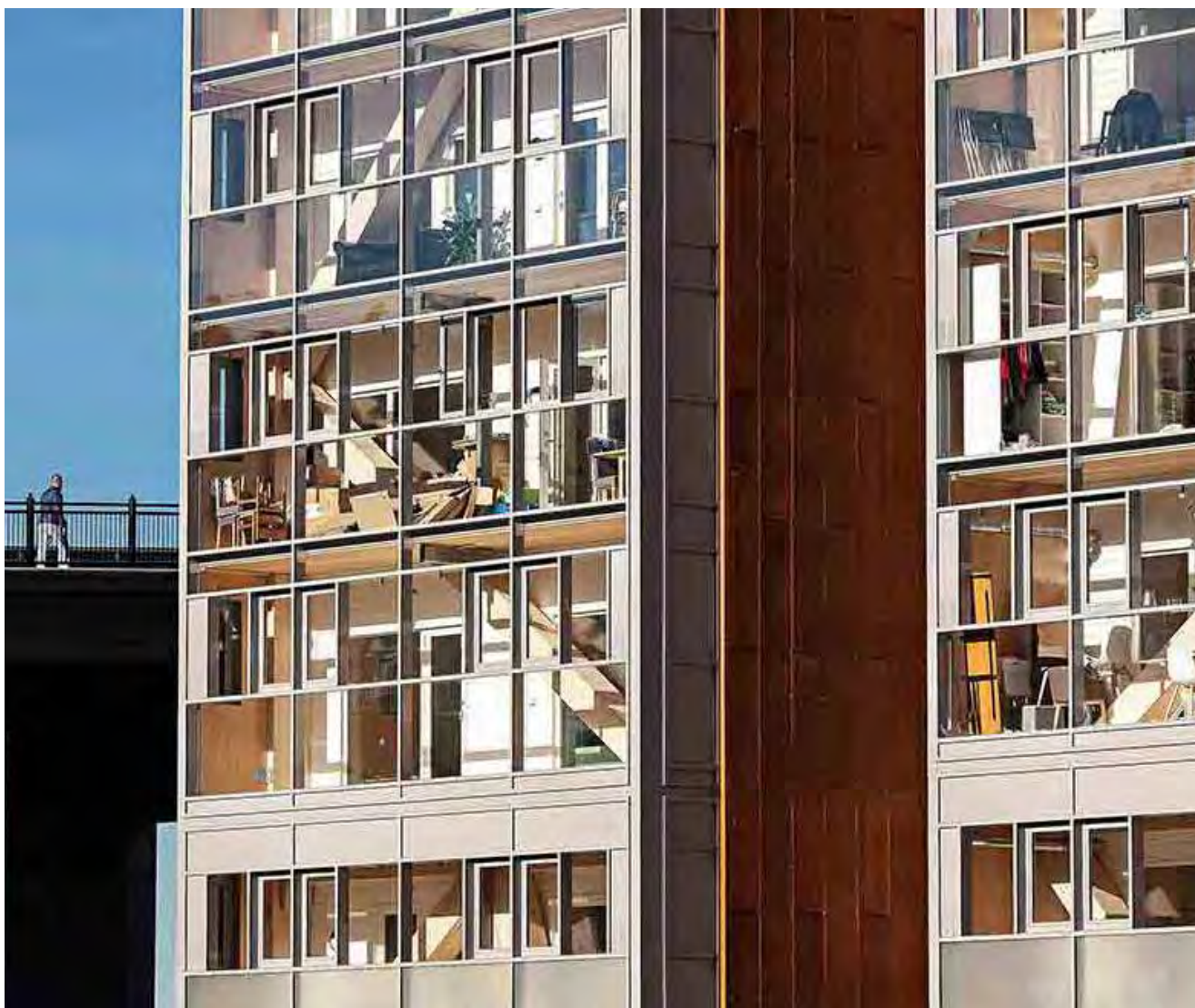
Risiko for brannsmitte mellom etasjer stiller branntekniske krav til fasadelivet forbi dekkeforkant. Illustrasjonsfoto
