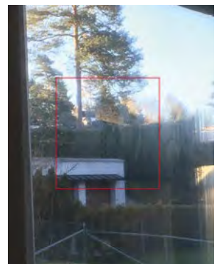
Silikonavsetning på glassoverflate fra løfteutstyr for glass.
